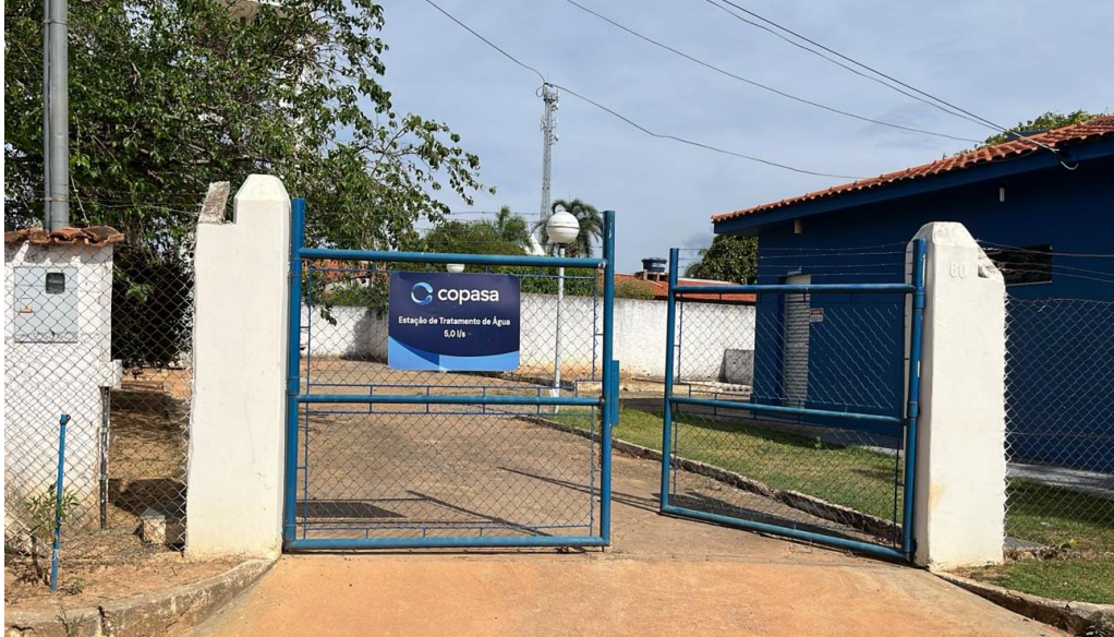
Figura 20: Estação de Tratamento de Água. Fonte: CODANORTE,2025
