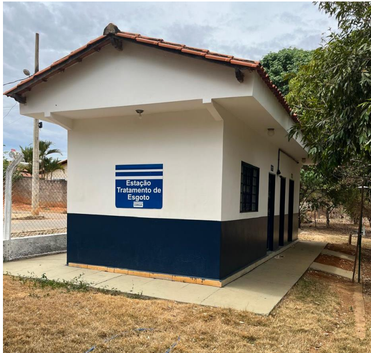
Figura 31: 2° ETE do Município de Claro dos Poções.
