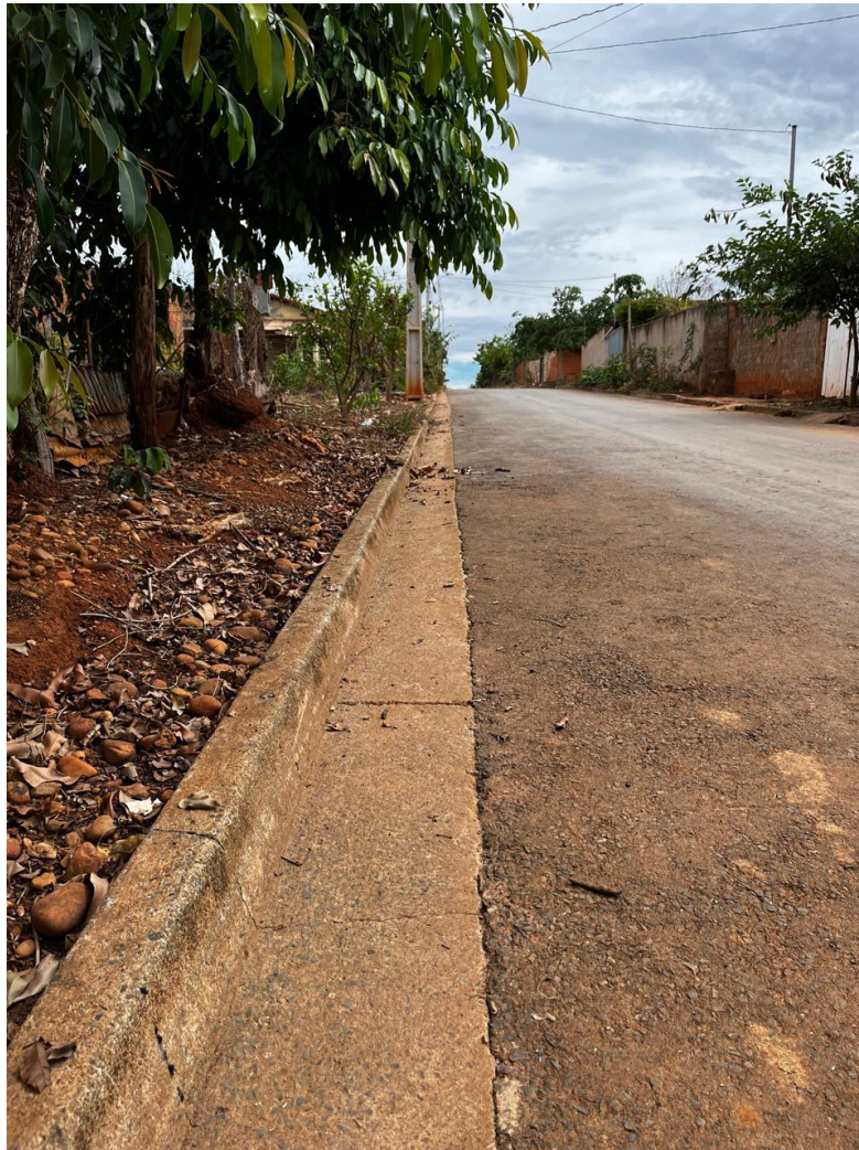
Figura 36: Sarjeta de drenagem pluvial
