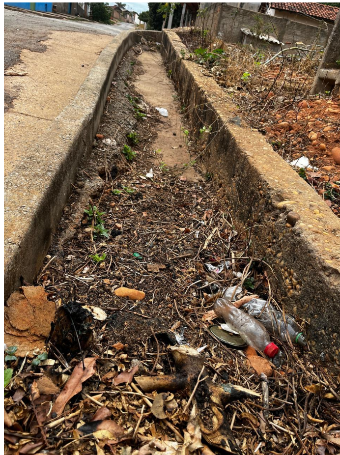
Figura 34: Canaleta de drenagem pluvial.
