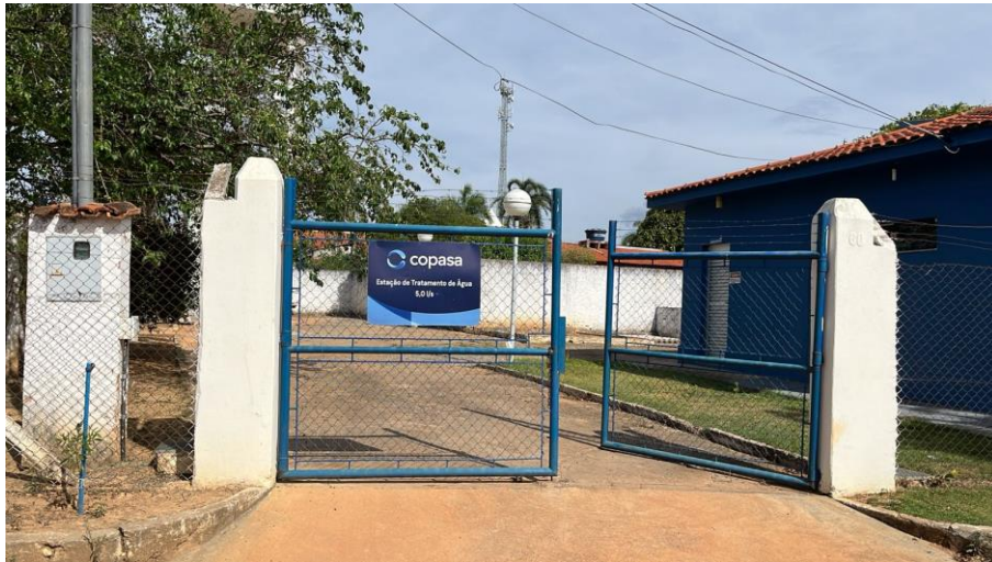
Figura 23: Estação de Tratamento de Água de Vista Alegre.
