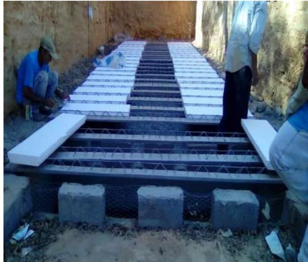
**Acabamento da Laje, isolamento e confecção das tampas para realizar a análise e limpeza das fossas.**
